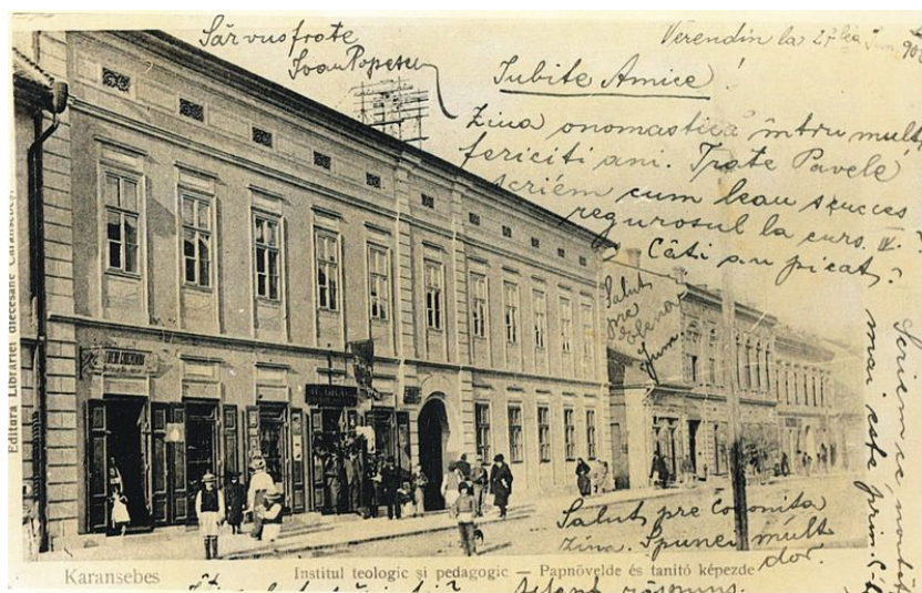
Clădirea Institutului Pedagogic și Teologic - Caransebeș
